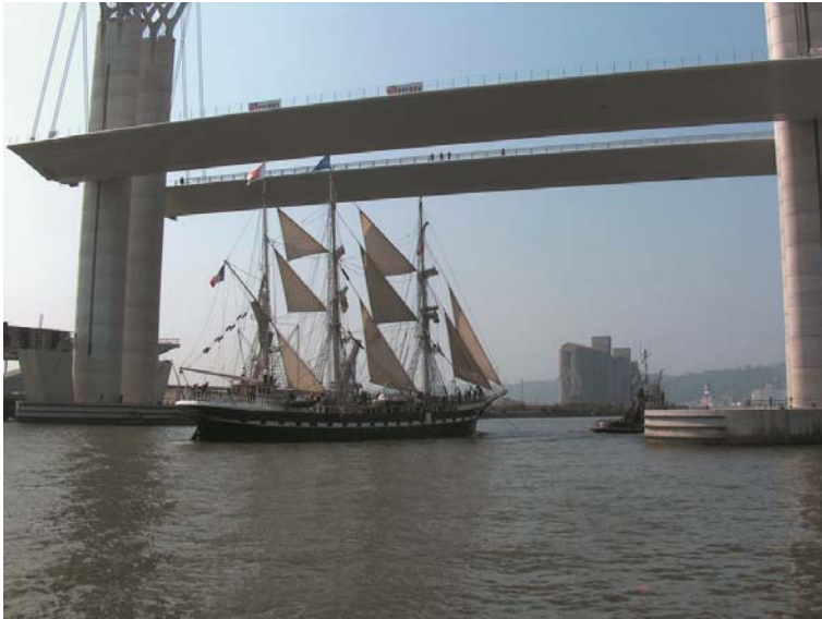
Міст імені Густава Флобера в Руані. Центральна частина мосту піднімається, щоб річкою могли проходити вітрильники.
